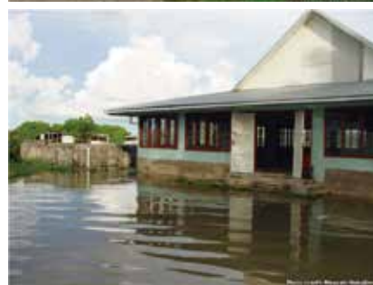
ツバル、フナフチ島。環礁のため内陸から沸き上がった水によって浸水している(上：浸水前→下：浸水後)。(どちらも、2002.5, Masaaki Nakajima)
